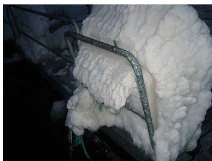
Figur 2 Is på rekkverk, bilde hentet fra http://www.flextech.no .
